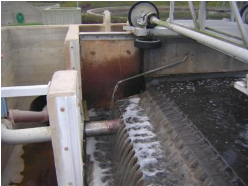
Dosering af fældningskemikalie inden forfældningstank
