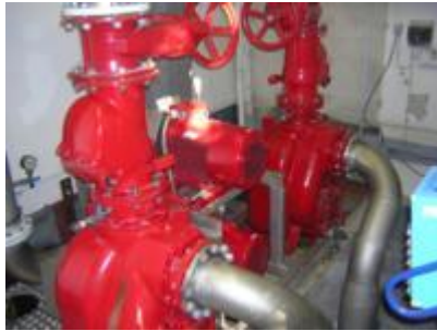
Spildevandspumper
