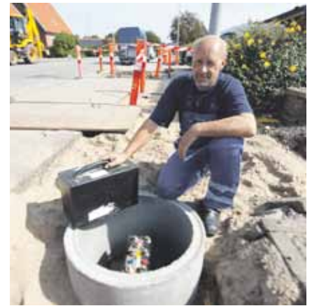
Ledningsarbejde i Ringgade
