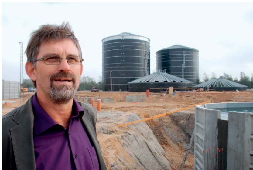
Direktør for Struer Forsyning, Knud Schousboe, glæder sig over, at byggeriet af Maabjerg Bioenergy endelig er kommet i gang efter et årelangt tilløb. Foto: Flemming L. Rasmussen.
